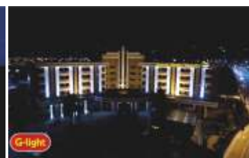
PROJETO EXECUTADO - GLF3
